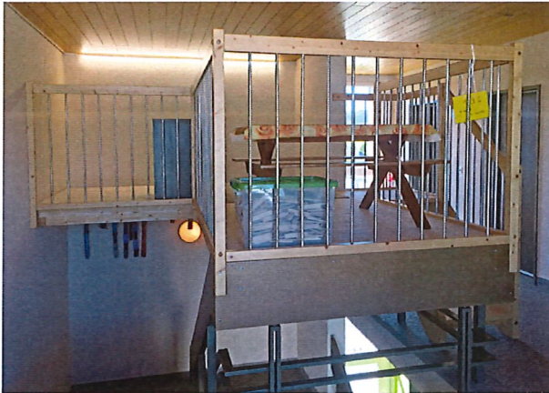
Podest Treppenhaus in Holz
