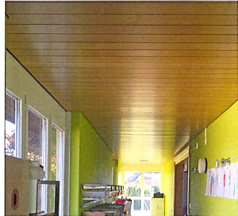
Deckenverkleidung in Holz
