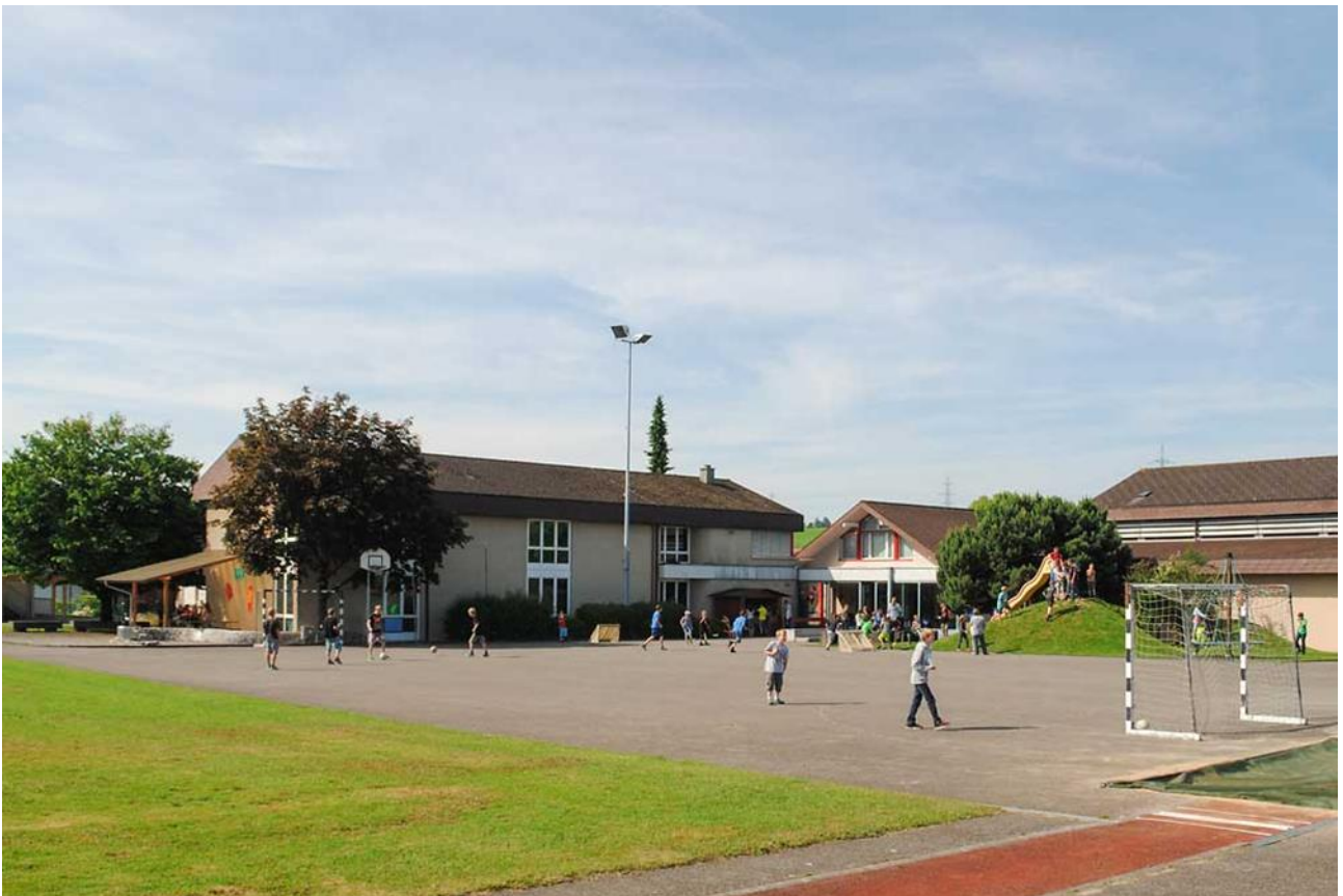
Heutige Schulanlage Grasswil, die den aktuellen und künftigen Bedürfnissen nicht mehr genügt.
